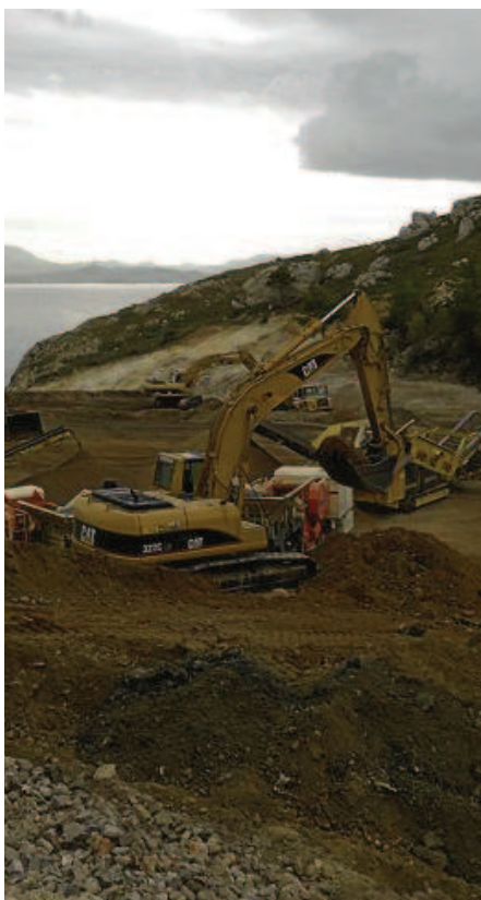
Suite à la cessation de son activité, Total Petrochemicals réhabilite l'ancien site industriel de l'Estaque, dont l'activité était la fabrication de produits chimiques. Marco Dufour/Total
