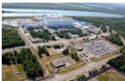
La centrale nucléaire de Fessenheim EDF
